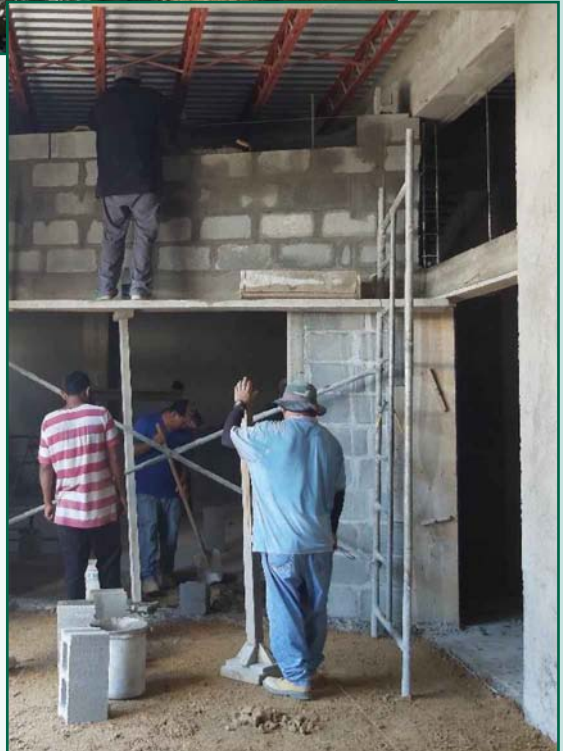
Levantamiento de pared en vestíbulo de acceso y compactación de selecto
