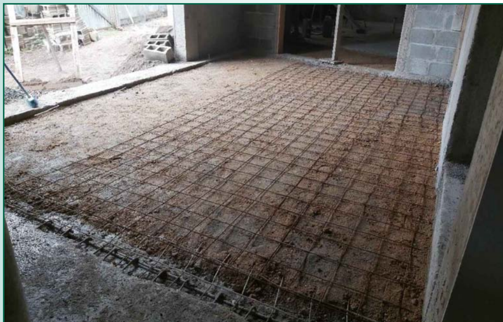
Colocación de malla electrosoldada en vistíbulo de acceso
