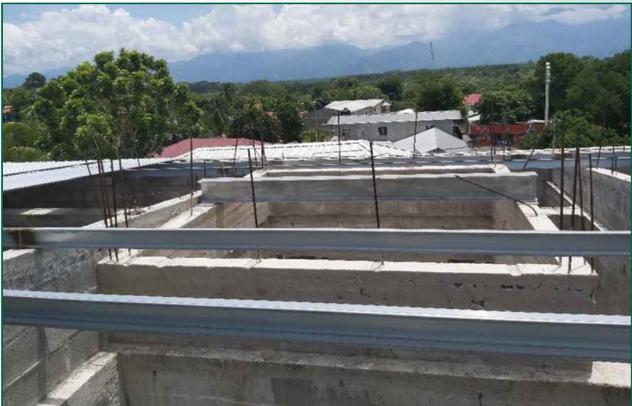
Instalación de Viga H en área de Ascenso tercer nivel
