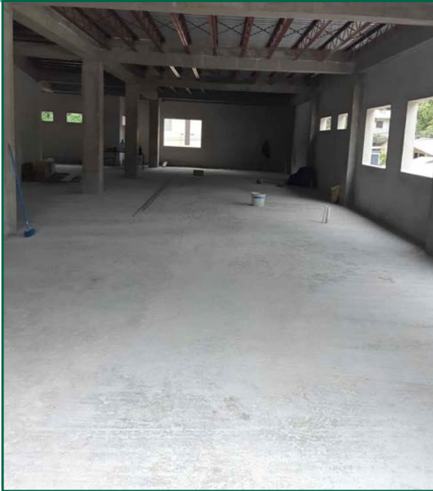
Fundición de 44,60 m2 de piso en área de emergencia
