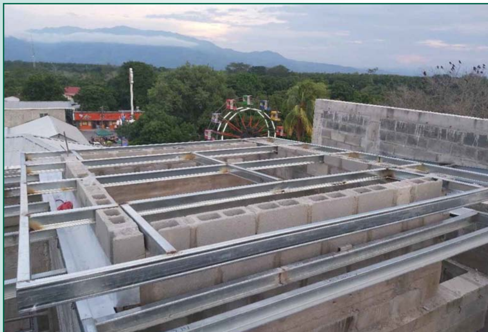
Istalación de canaletas para techo de ascensor
