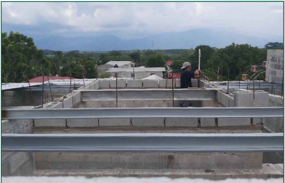
Levantamiento de pared en cubo de ascensor
