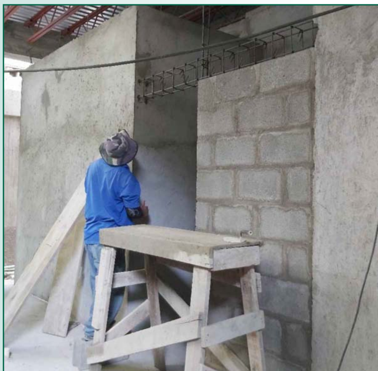
Colocación del armado de solera en pared del área de triturador
