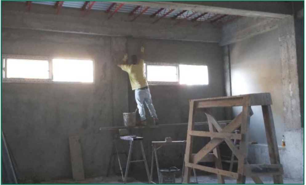
Pulido de paredes en área de emergencia
