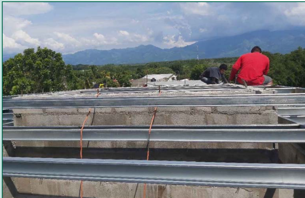
Istalación de canaletas para techo de ascensor
