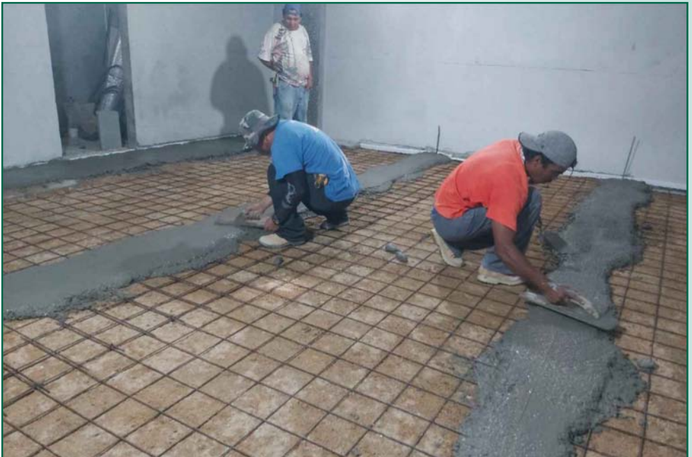
Fundición de 29 m2 de piso en área de Labor de Parto
