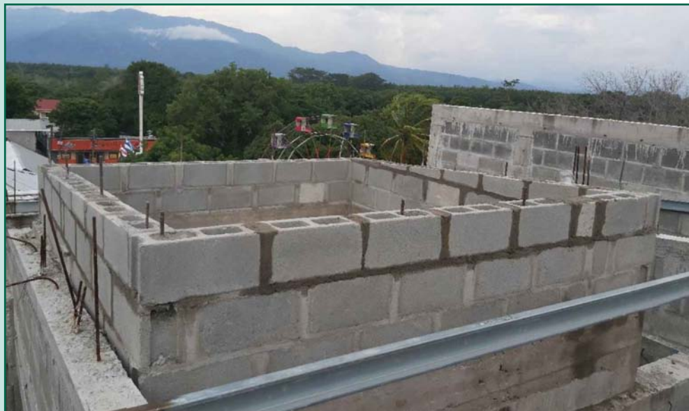
Levantamiento de pared en cubo de ascensor
