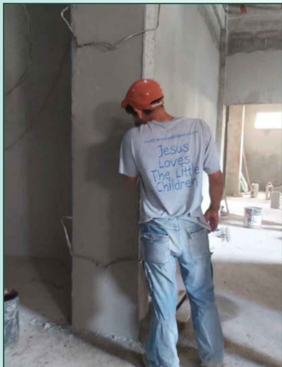
Pulido de columnas en área de Insumus
