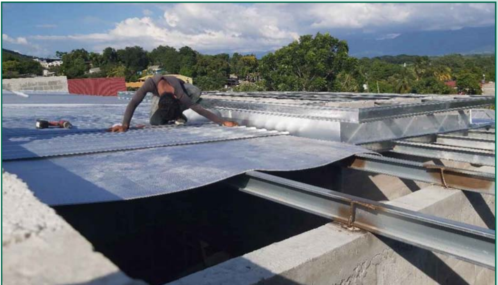
Instalación de láminas galvanizadas en techo de ascensor
