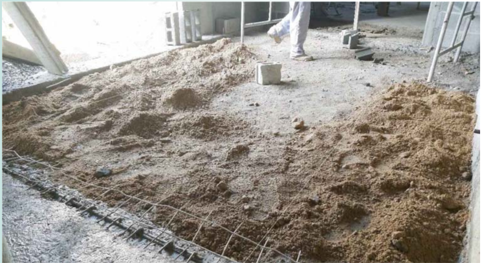
Relleno con selecto en área vestíbulo de acceso
