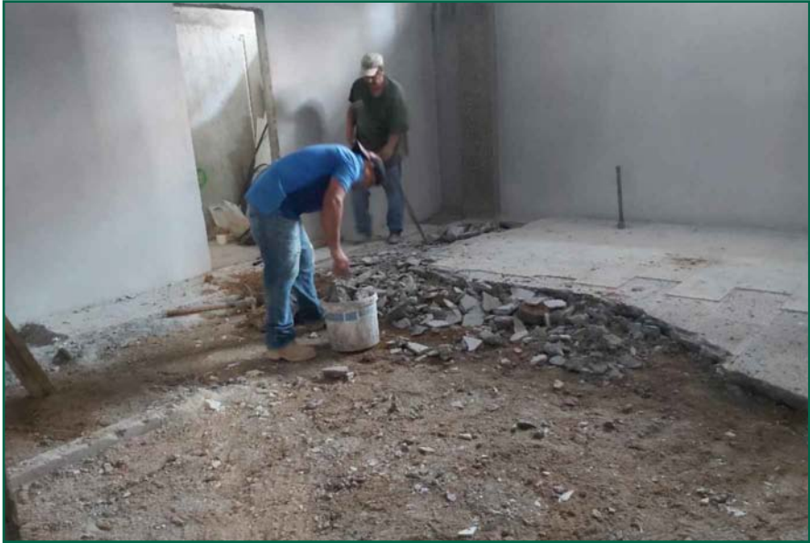
Demolición de piso existente en área de Labor de Parto
