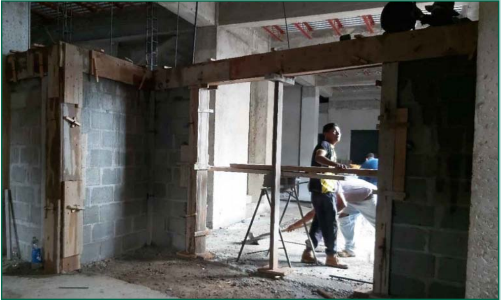
Fundición de solera superior en área de emergencia
