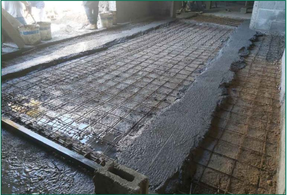
Fundición de 28 m2 de piso de concreto en área vestíbulo de acceso
