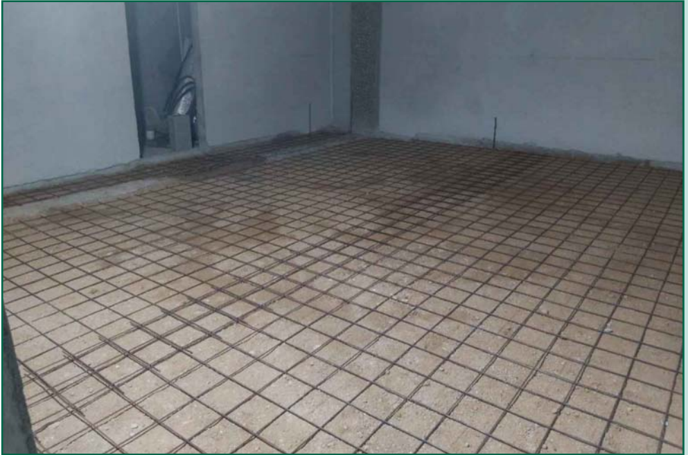
Colocación de malla electrosoldada en área de Labor de Parto
